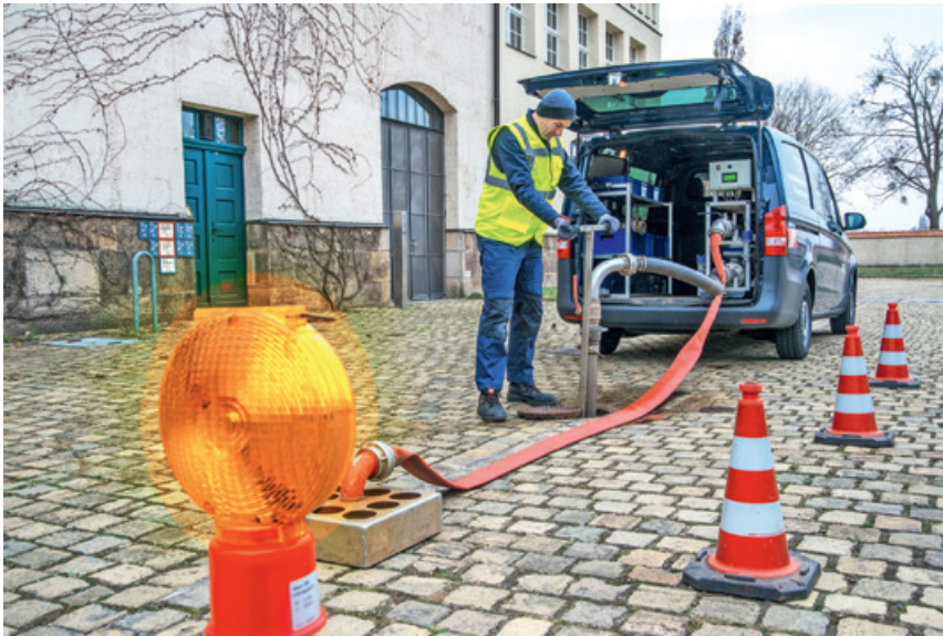
Abb. 2: Fahrzeug mit Spülstand zur Erfassung der Ablagerungssituation
