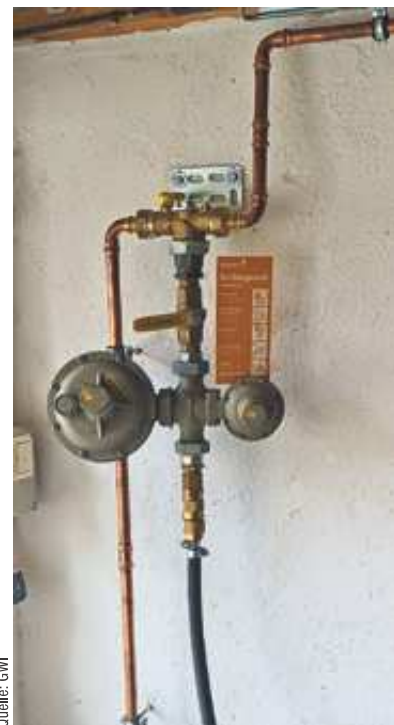
Abb. 5: Prüfgasadapter mit Gasdruckregler und Schlauchzuleitung am Gaszähleranschluss
