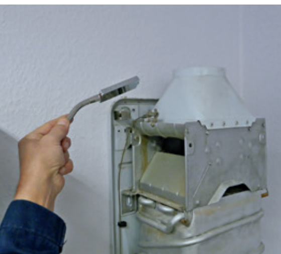
Abb. 3: Prüfung der ordnungsgemäßen Abgasabführung mittels Taupunktplatte gemäß TRGI Absatz 11.4.2 bzw. 11.2.1 Satz 1
