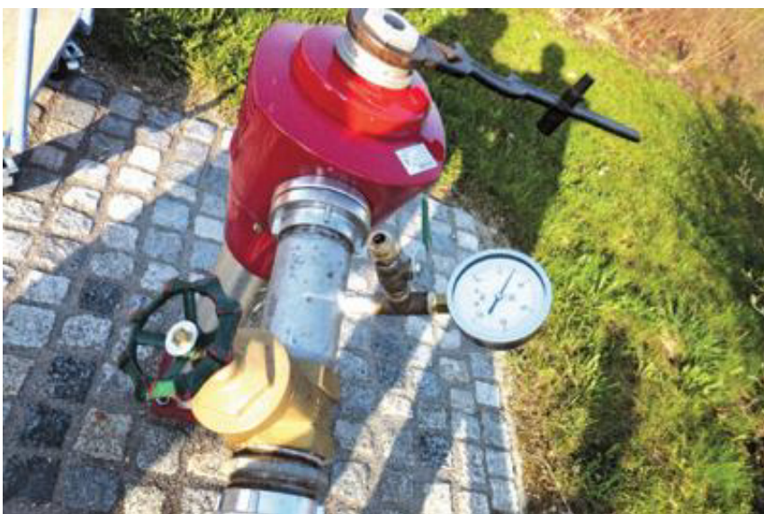
Abb. 2: Hydrant der Feuerwehr mit Manometer
