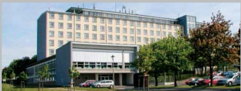
Neue Räumlichkeiten innerhalb des Deutschen Brennstoffinstitutes, Halsbrücker Straße 34 in Freiberg haben das DBI GUT und das DBI GTI bezogen.
