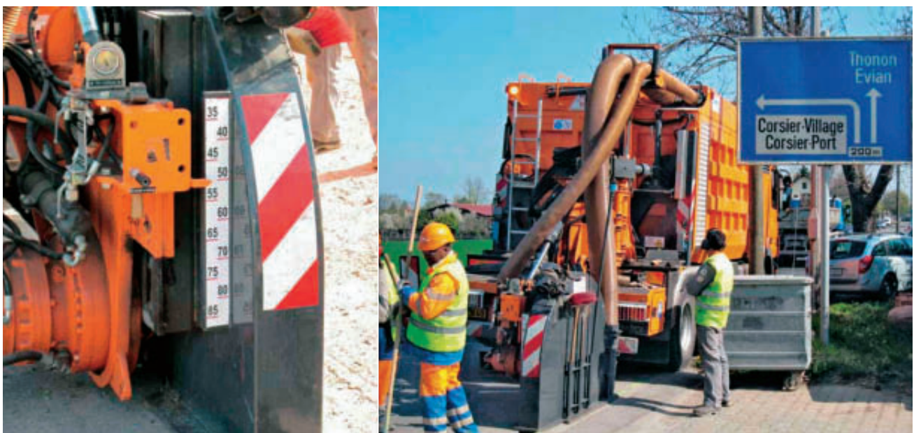
Abb. 1 a + b: Kombination von Fräse und Saugbagger bei flacher Leitungsverlegung
