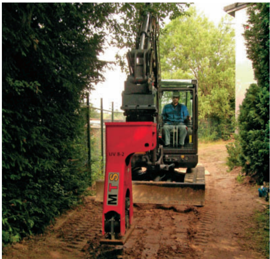
Abb. 4: Volvo-Bagger ECR48C mit MTS-Anbauverdichter
