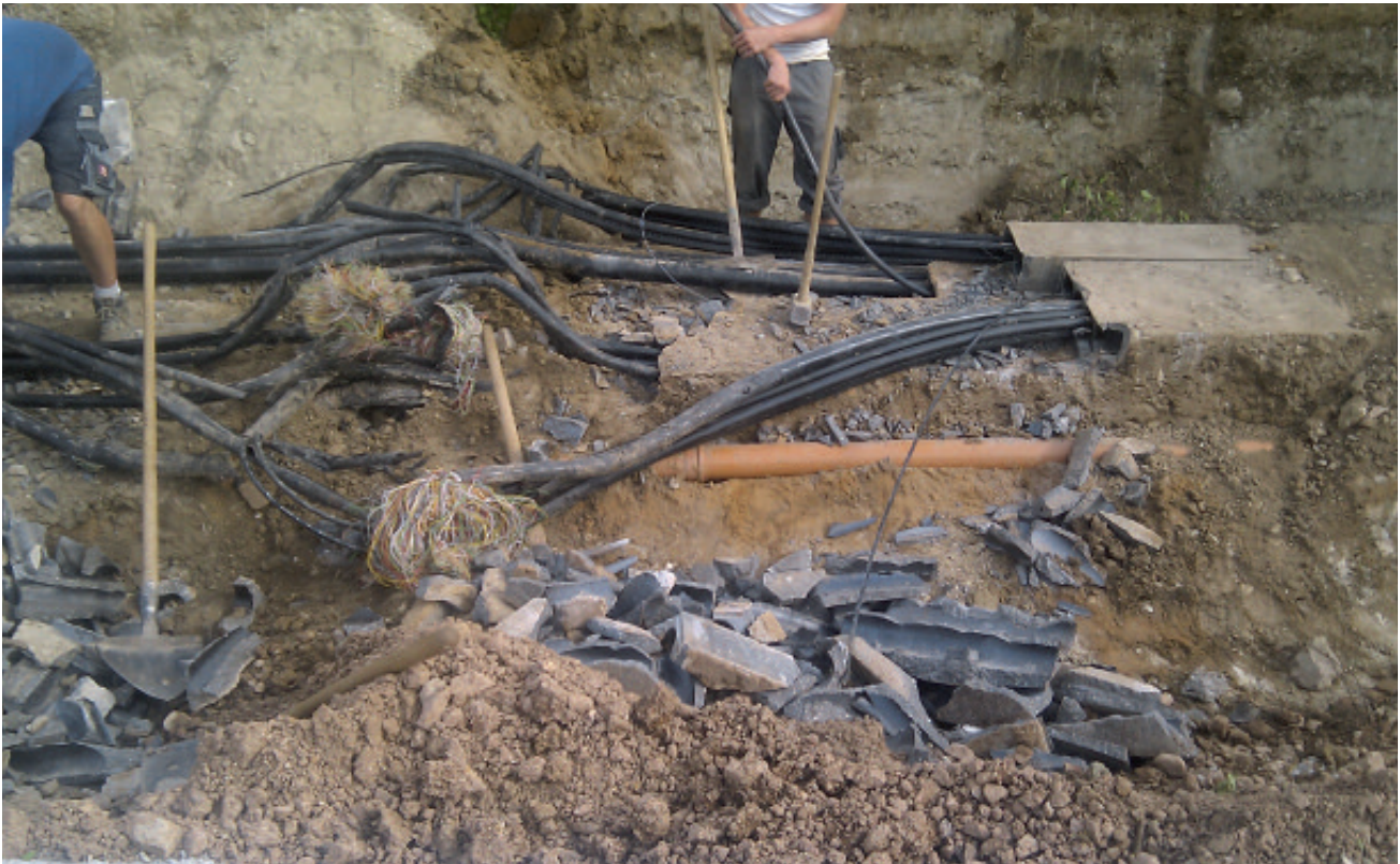
Abb. 3: Die Zerstörung einer Telekommunikationsleitung kann beim Nutzer zu gravierenden wirtschaftlichen Folgen aufgrund Unterbrechung der Kommunikation und des Datentransfers führen.
