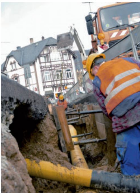
Abb. 1: Sich querende Leitungen und enge innerstädtische Verhältnisse erfordern erhöhte Sorgfalt schon in der Planungsphase
