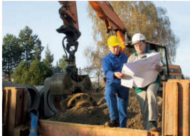
Abb. 1: Bei Baubeginn müssen beim Bauausführenden aktuelle Planunterlagen vorliegen. Der für die Baustelle Verantwortliche des ausführenden Tiefbauunternehmens muss sich selbst durch geeignete Erkundungsmaßnahmen Gewissheit verschaffen, wo die Leitungen tatsächlich liegen.
