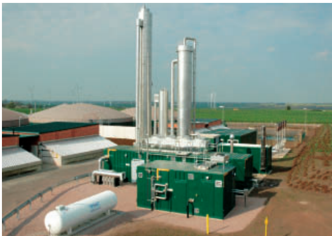
Abb. 3: Druckwasserwäsche der Firma Malmberg
