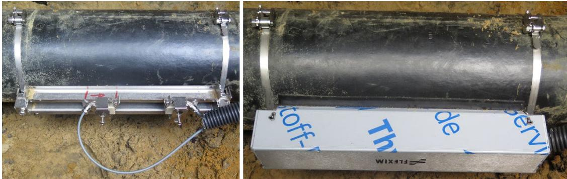
**Abbildung 5: Ultraschallsensoren, funktionsbereit (links), für Erdverlegung vorbereitet (rechts) (GELSENWASSER 2018)**
