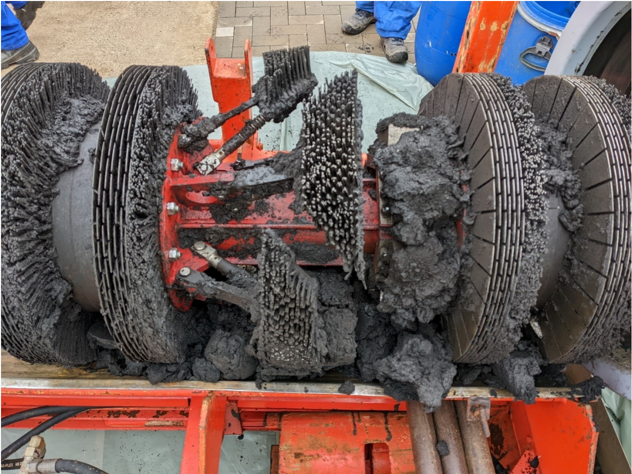
Abbildung 10: Ablagerungen aus einer Transportpipeline, zweite Reinigungsmolchung
