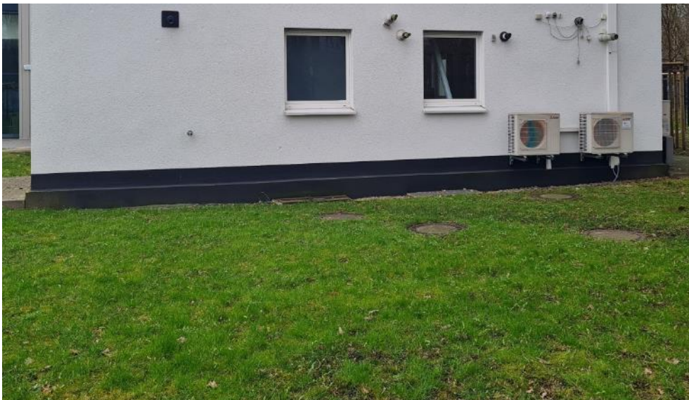
Abbildung 3.10: Unterirdisch ausgeführte Hauseinführung ins Demo-Haus
