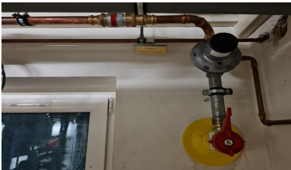
Abbildung 3.11: Hauseinführung und Hausinstallation
