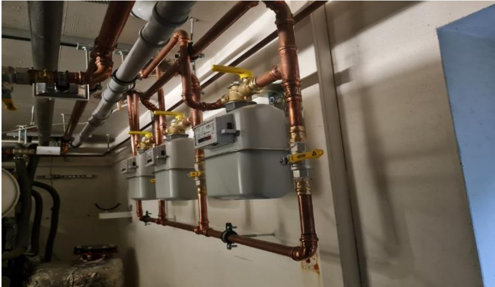
Abbildung 3.12: Einzeln abrechenbare Geräteanschlussleitungen
