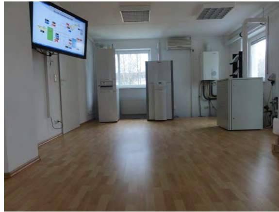
Abbildung 10-6: KWK-Geräte (links), Wärmepumpen, Brennwertkessel und Brennstoffzelle (rechts)
