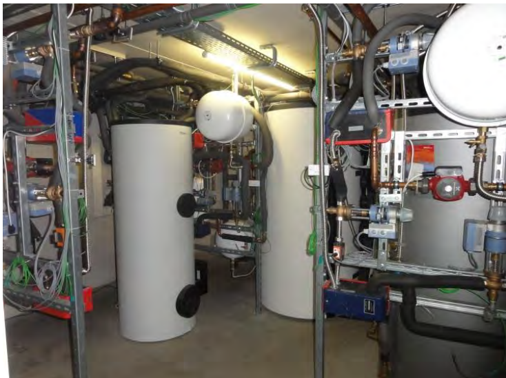
Abbildung 10-7: Installationsstationen und Speicher in den Kellerräumen
