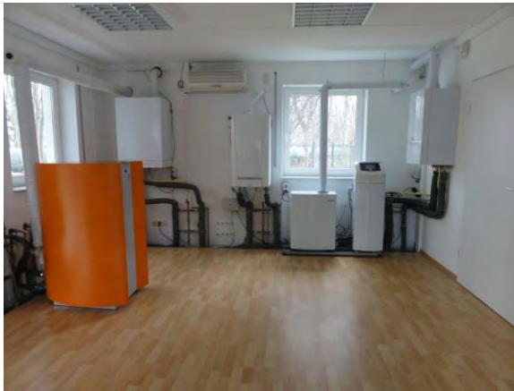
Abbildung 10-6: KWK-Geräte (links), Wärmepumpen, Brennwertkessel und Brennstoffzelle (rechts)
