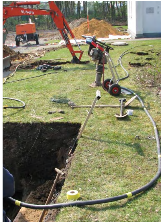
Kollektor 1 – Installation im Raketenschussverfahren
