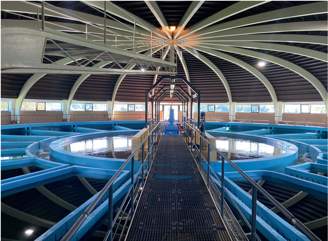
Abb. 2: Flockungsaccelator im Wasserwerk Mülheim-Styrum West
