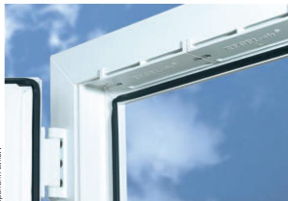
Abb. 1: Fensterfalzlüfter im eingebauten Zustand
