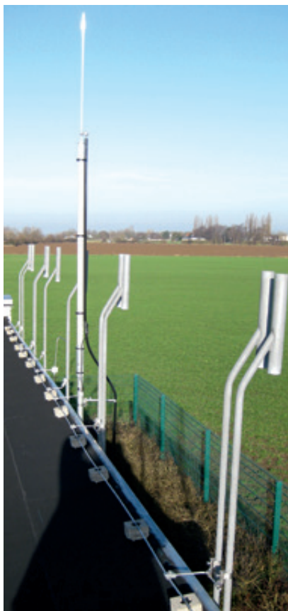
Vertikale Ausbläser Typ A an einer GDRM-Anlage
