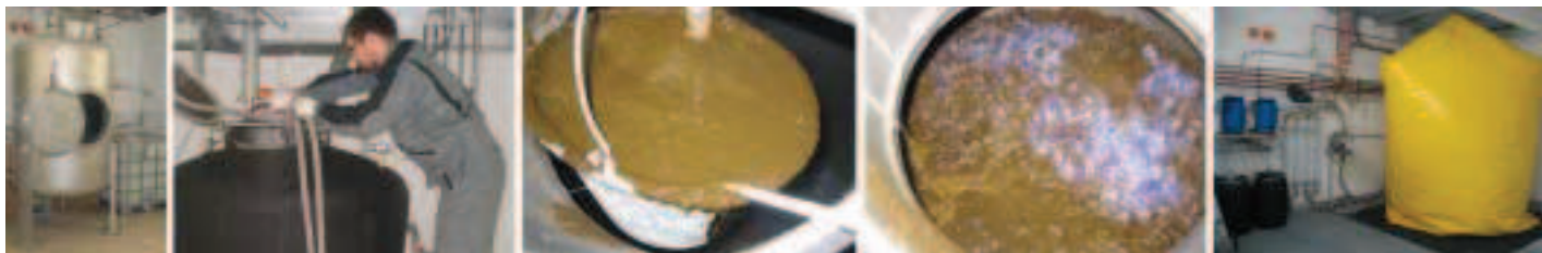
Bild 3. Inbetriebnahme der DBI-Biogasanlage (v.l.n.r.: Fermenter, Erstbefüllung des Fermenters, Hydrolyseeinheit mit Gasspeicher).
