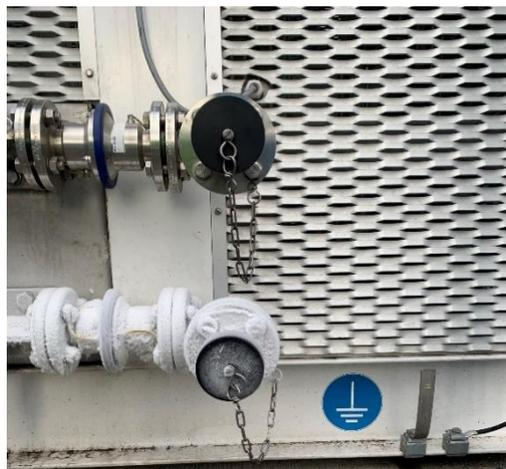
Abbildung 4-5: Erdungsfestpunkt an der Tankkraftwagenstation [11]
