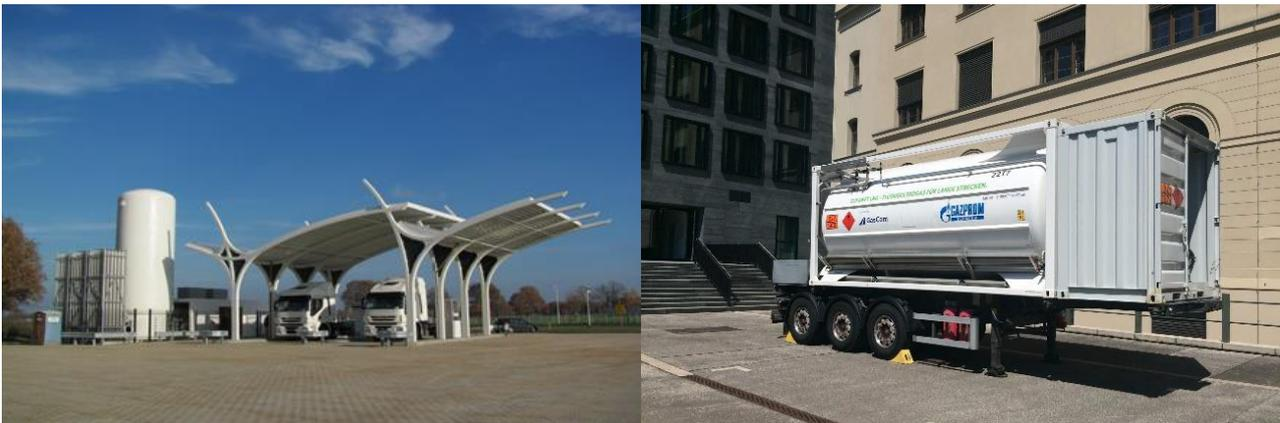
**Abbildung 4-3:** Fest installierte LNG-Tankstelle (links) (Rolande LNG) und mobile Tankanlage (rechts) © Felix Apfel
