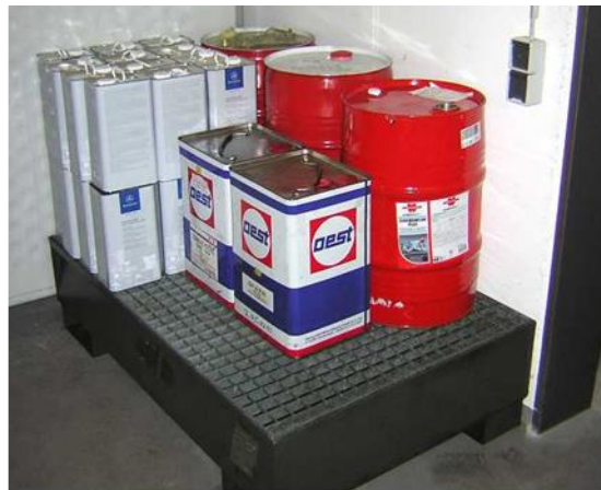
Aufbewahrung von größeren Mengen auf einer Auffangwanne; © IBU Baden-Württemberg
