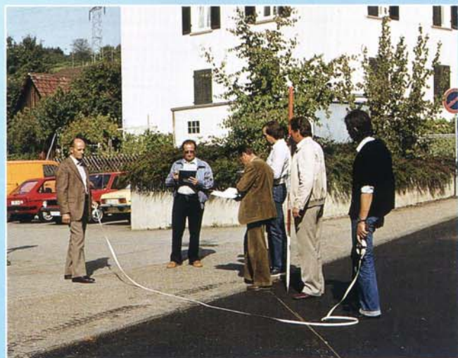
Einmessen von Leitungen
