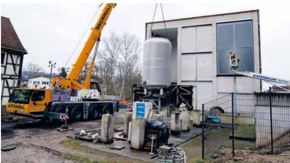
Einbau des dritten Aktivkohlefilters im Wasserwerk Wehrda
