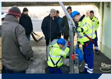
Demonstration einer transportablen Einstiegshilfe für Schächte durch Mitarbeiter des KAT
