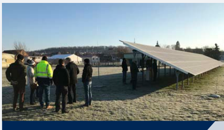
Die PV-Anlage des KAT hat eine Leistung von 82 KWp. Jährlich wird eine Einsparung von 36.450 kg/CO 2 -Äquivalenten erreicht
