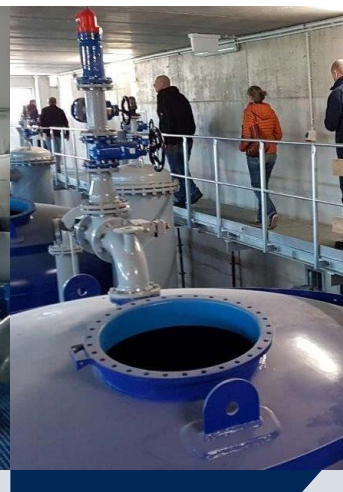
Besichtigung der neuen Filterhalle
