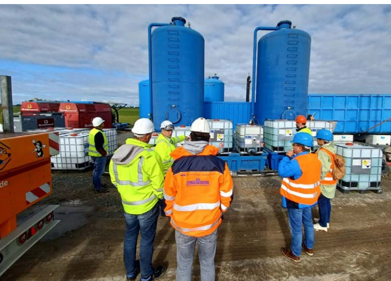
Besichtigung einer Grundwasseraufbereitungsanlage durch die Bezirksgruppe Rostock
