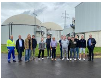
Biogasanlage / © DVGW-LG NRW
