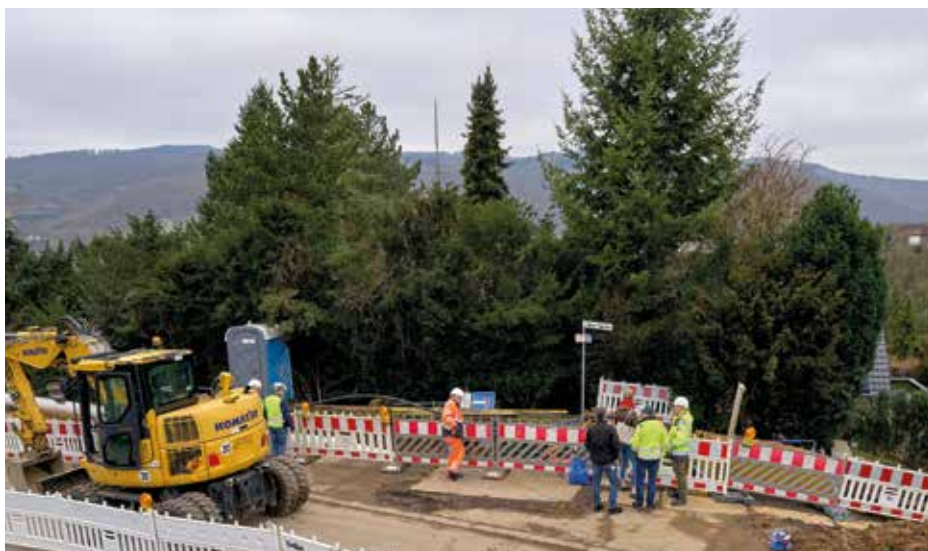
Baustelle im Oberen Charweg in Lahnstein: Hier wurde eine neue Wassertransportleitung eingezogen
