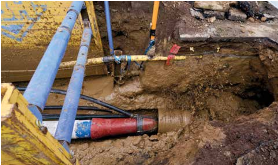
5,5 Tonnen Gewicht: Die neue Leitung wurde unterirdisch über einen 156 Meter langen Bohrtunnel eingezogen
