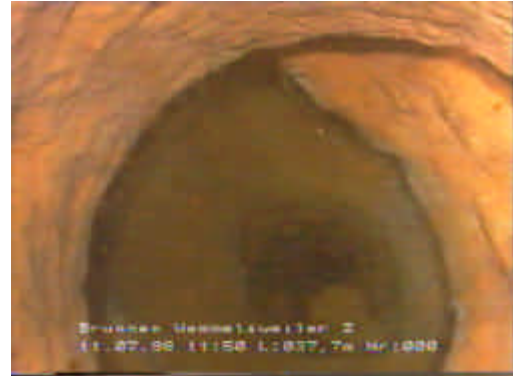
Bild 2: Veränderung der Radialsymmetrie durch seitlich in das Bohrloch eingerutschten, sichelförmigen Gesteinsblock, der den Querschnitt um ca. ein Drittel verringert.
