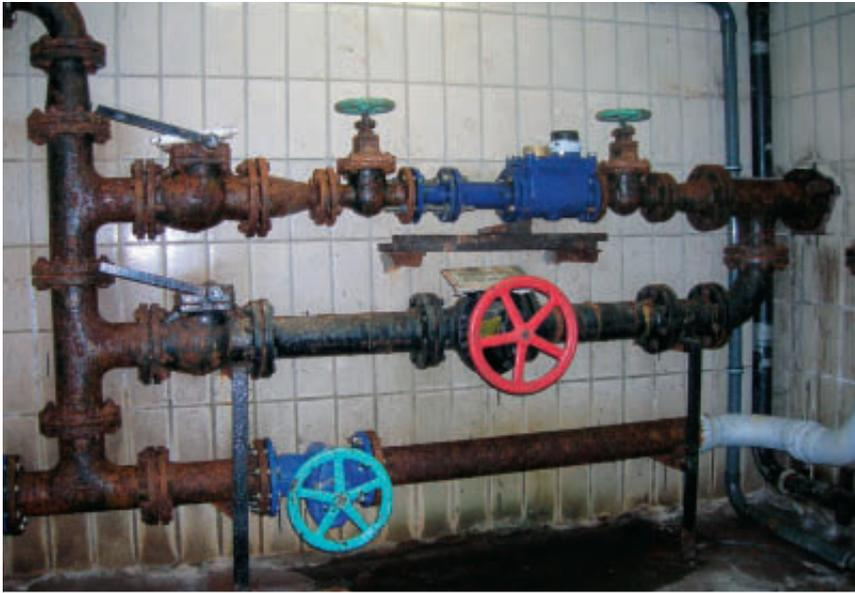
Abb. 6: Geschlossene Umgehungsleitung an einer Wasserzähleranlage
