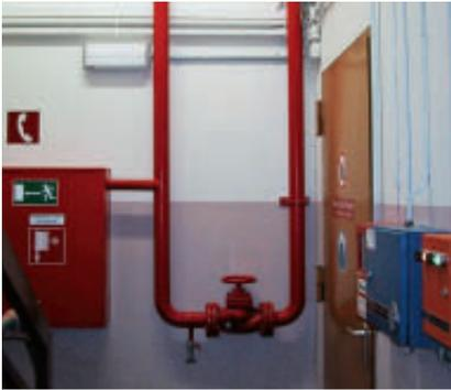
Abb. 4: Wandhydranten mit dem Typ S sind einzuschleifen
